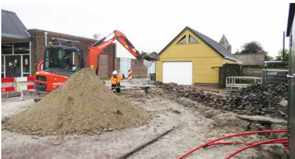
Graafwerk voor de aanleg van de riolering van het Christinaplein naar de Kerkstraat. (foto: Johan Kootstra)
