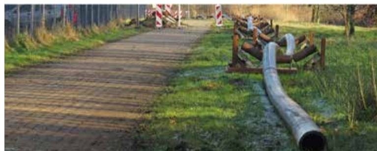
Het afgesloten fietspad bij het transformatorhuisje. (foto: Johan Kootstra)
