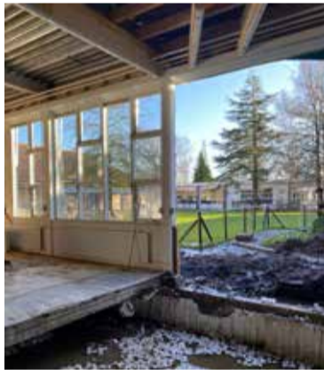
De school gaat flink op de schop. (eigen foto's)
